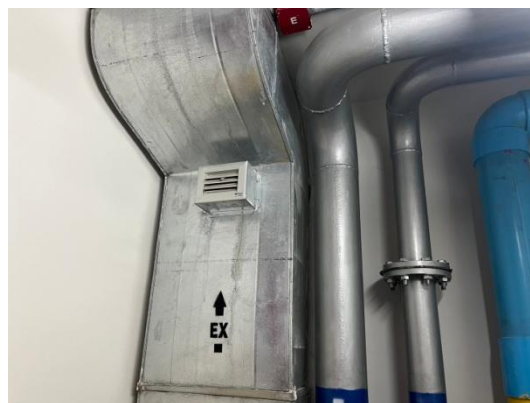
ระบบระบายอากาศภายในห้องพัสดุฝอยประจำชั้น
