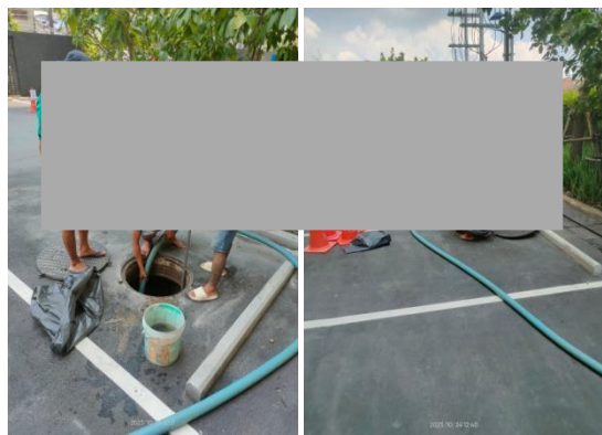
รูปที่ 2-33 การสูบน้ำและสิ่งปฏิกูลจากระบบบำบัดน้ำ เสีย
